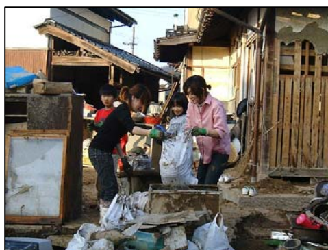
泥出し・瓦礫撤去
