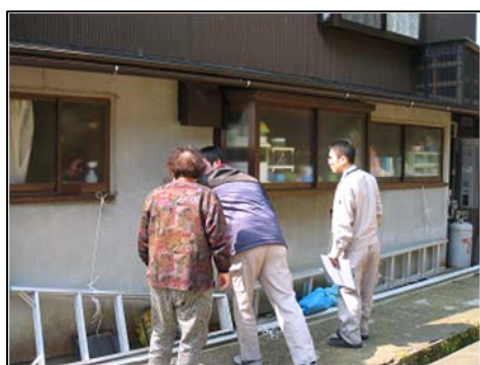
専門家による家の耐震診断
