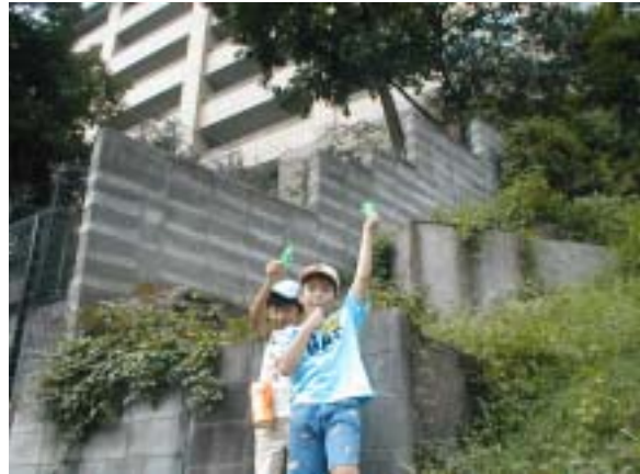
(写真：斜面と擁壁)
