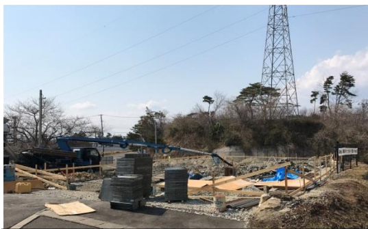
基礎工事が進む『みんなの家はまのわ』
