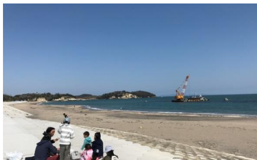
防潮堤も完成！七ヶ浜の夏もすぐそこ！
