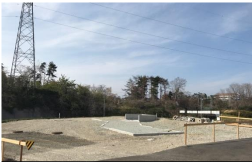
基礎も出来ていよいよ「柱建て」の準備中。
