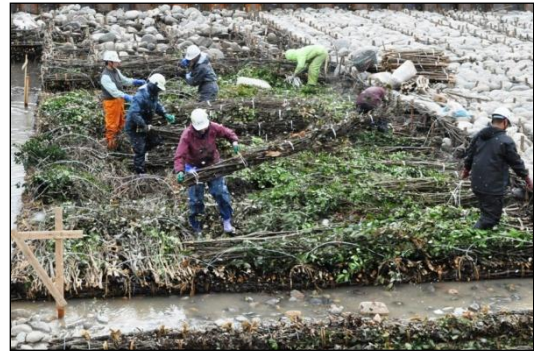
岐阜市の長良川河川敷での粗朶沈床工の施工風景 (2010 年 2 月撮影)
