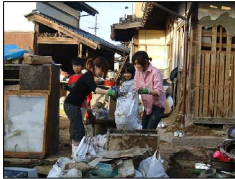
泥出し・瓦礫撤去
