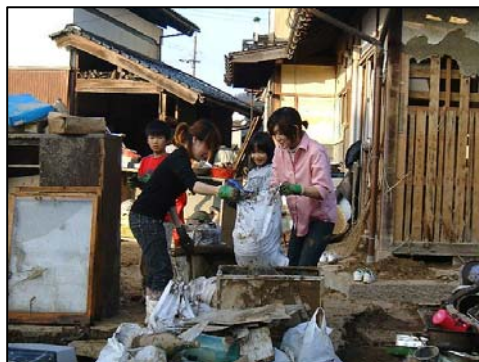
泥出し・瓦礫撤去
