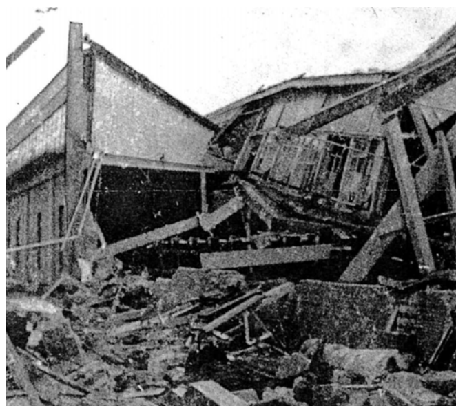
倒壊した中島飛行機山方工場。半田工業の生徒ら157人が犠牲となった(中日新聞社刊『恐怖のM8』より)
